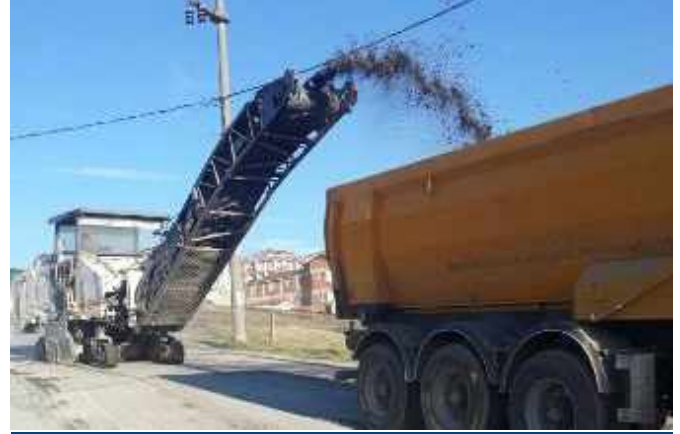
Deforme Olan Yollarda Trimer ile Asfalt Kazıma
