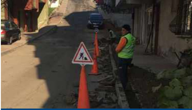
Türk Telekom Kazı Çalışması
