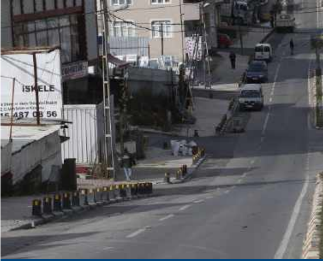
Petrol yolu Caddesi Prestij Yol Uygulaması
