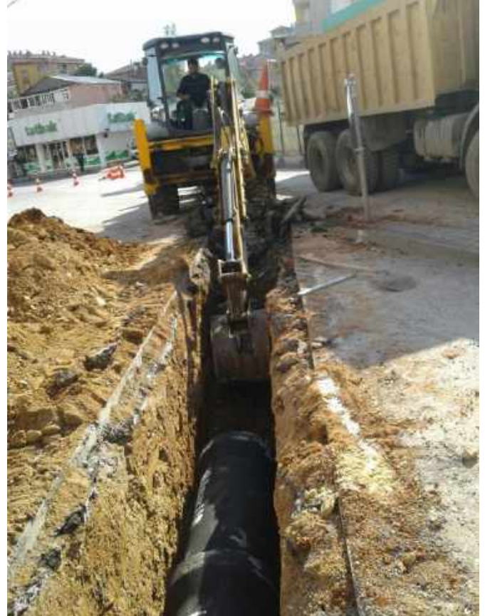
Yağmursuyu Hattı Çalışması
