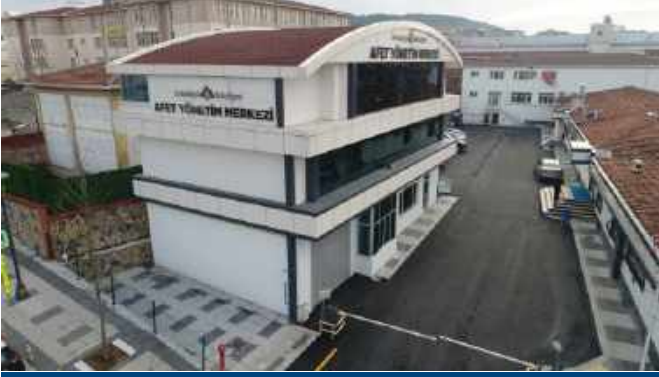
Afet Yönetim Merkezi Binası
