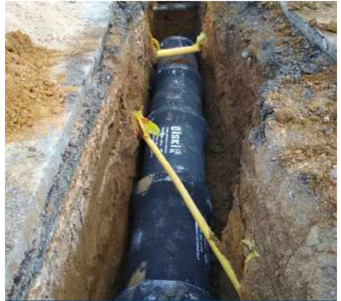
Yağmursuyu Hattı Çalışması
