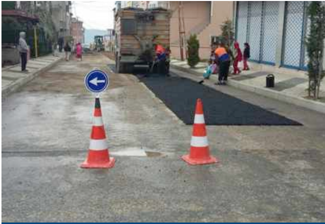
Kısmi Deforme Olmuş Yerlerde Asfalt Yama Çalışması
