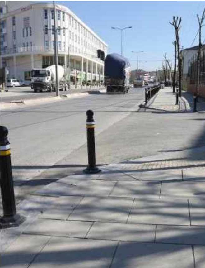
Bosna Bulvarı Prestij Yol Uygulaması
