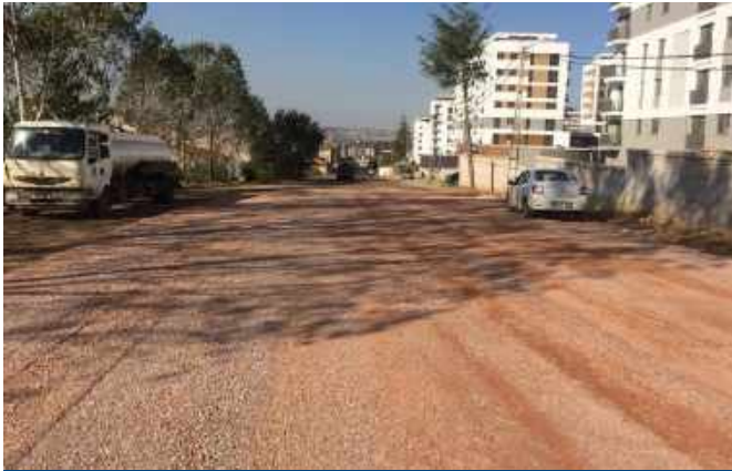
Yeni İmar Yolu Açılması ve Zemin İyileştirme Çalışmaları
