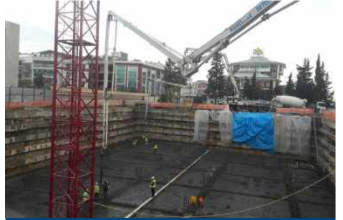
Karizma Sokak Zeminaltı Otopark İnşaatı
