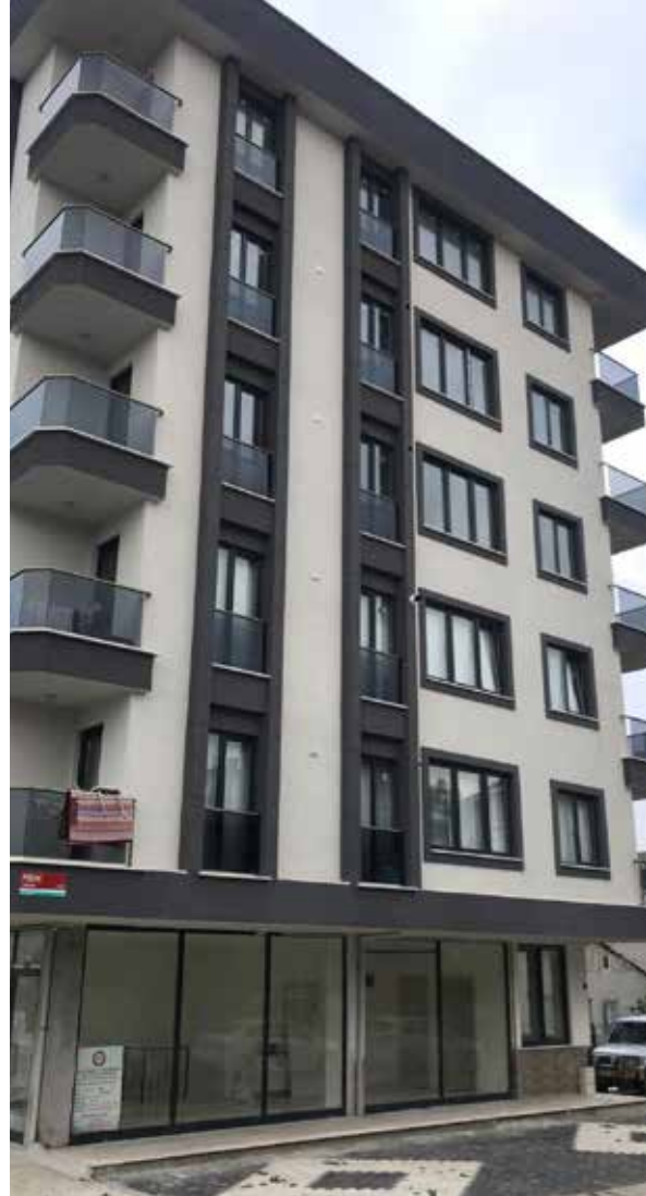
Yapı Kullanma İzin Belgesi Düzenlenen Binalar
