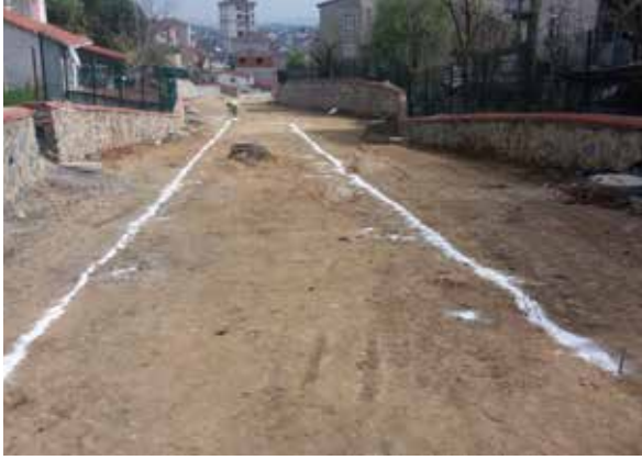
Aşık Veysel Parkı Yapım Öncesi
