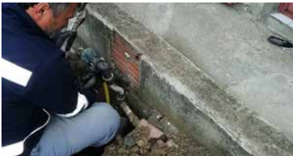
Doğalgaz Kutusu Tesisat Tamirati
