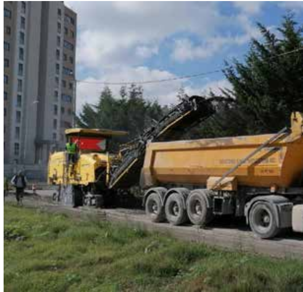
Deforme Olan Yollarda Trimer İle Kazıma
