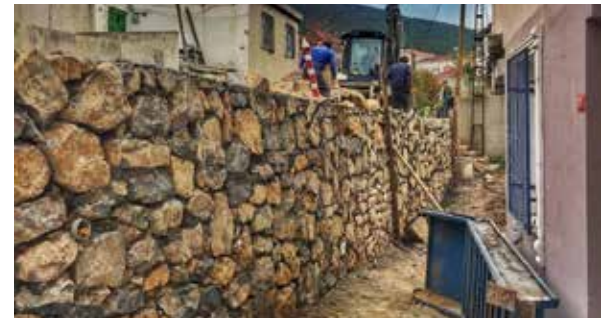
Taş Duvar Çalışmaları
