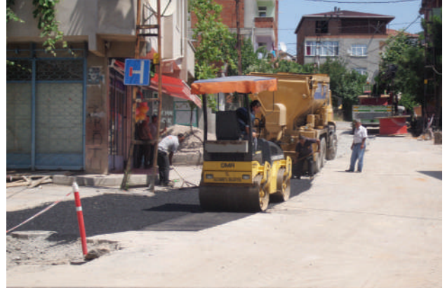
Asfalt Yama Çalışması
