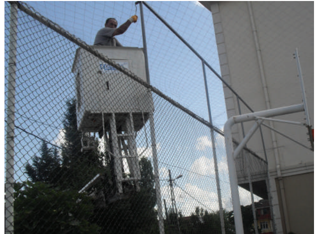
Birçok Okulda Basket Potası ve Futbol Kaleleri Hazırlanarak Montajı Yapıldı.
