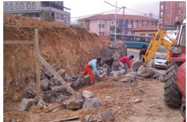
Pendik Caddesinde Yapılan Taş Duvar Çalışması
