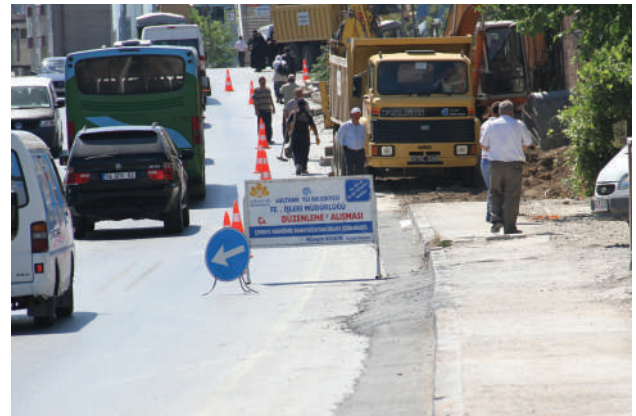
Fatih Mahallesi Güney Yanyolda Yol Geniştirme Yapıldı.
