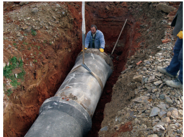
Yağmursuyu Hatlarının Döşenmesi
