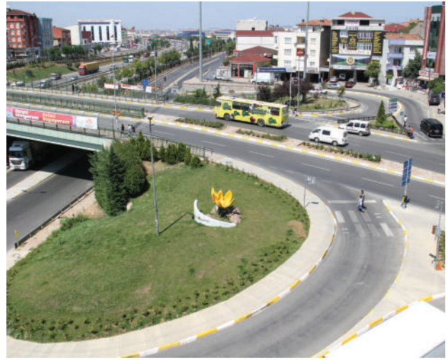
Fatih Bulvarı'nı Demokrasi Caddesi'ne Bağlayan Çamlık Durağı Kavşağı Tamamlandı.
