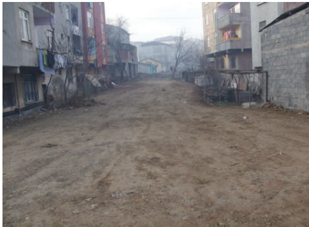
Hamidiye Mahallesi Beşir Balcıoğlu Deresinin Islahı Yapılarak Çevre Kirliliğinin Önüne Geçilirken Petrol Yolundaki Yağmursuyu Hattı Güney Yan Yola Bağlanmıştır.
