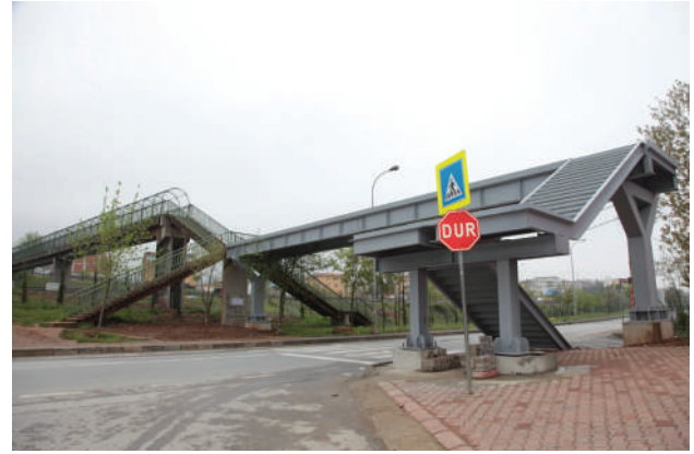
T. Reis Mahallesi Uzatılan Üstgeçit
