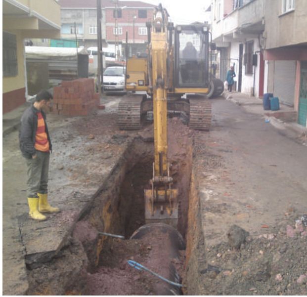
Atık su Kanalının Döşenmesi
