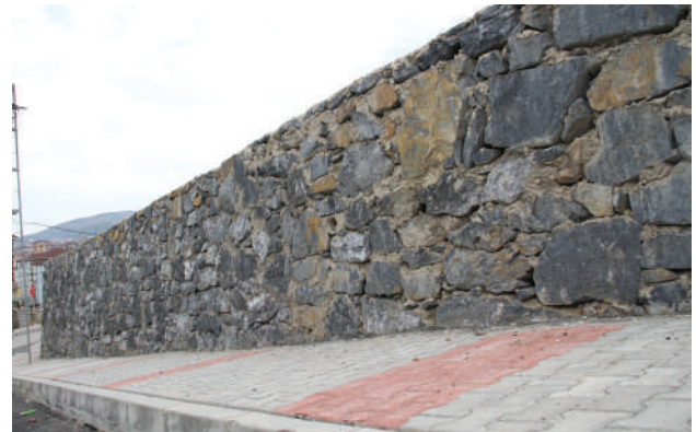
Taş Duvar Çalışması
