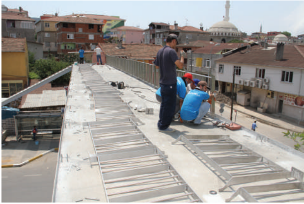
Üstgeçit Korkuluk Montajı
