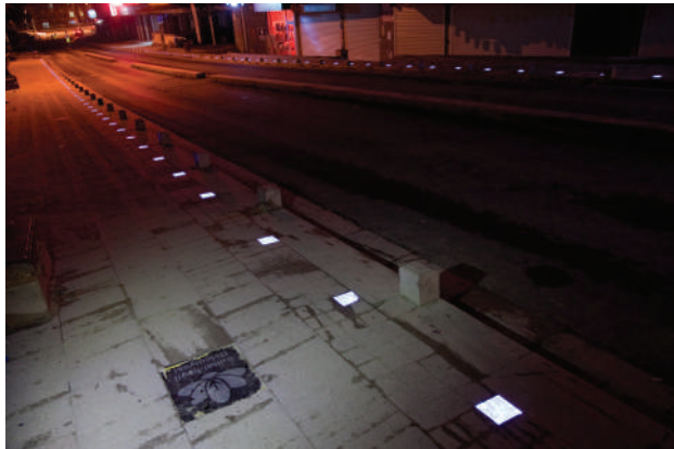
Bordür Dibi Işıklandırma Yapılan Sokak Estetik Bir Görünüme Kavuştu.
