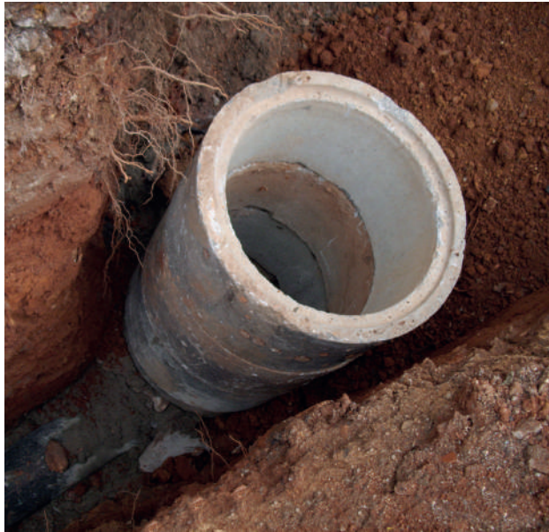
Atık su Kanallarına Bağlı Parsel Bacaları Yapılmıştır.
