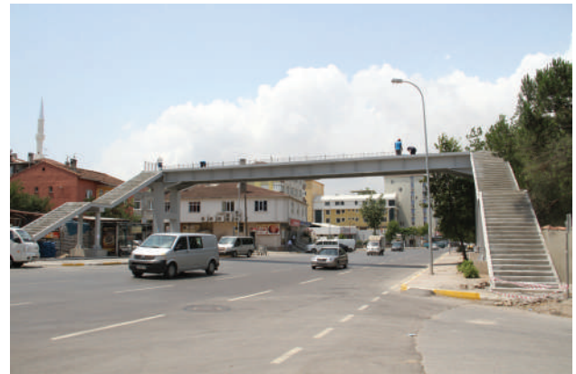
Hasanpaşa Mahallesi Fatih Bulvarı Üst Geçidi
