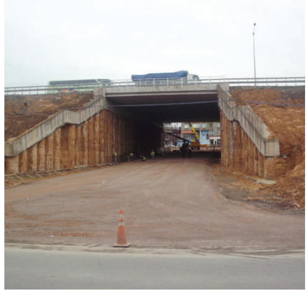
Birinci Kısım Mecidiye Kavşağı'nın 270 m Batı İstikametinde, Kuzey ve Güney Yan Yolları Birbirine Bağlayacak Olan Taşıt Alt Geçidi Yapımı
