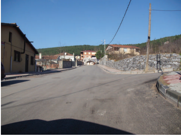
Osmangazi Caddesinde Tretuvar Çalışması Boyunca Yol Geniştirme, Taş Duvar, Direklerin Deplasesi
