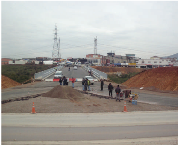
İkinci Kısım 300 m Doğu İstikametinde, Yan Yolları Birbirine Bağlayan Taşıt Üst Geçidi Yapımı
