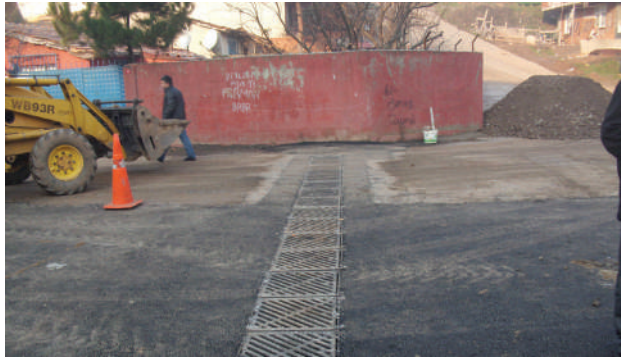
Yapılan Bağlantılı Izgaralar
