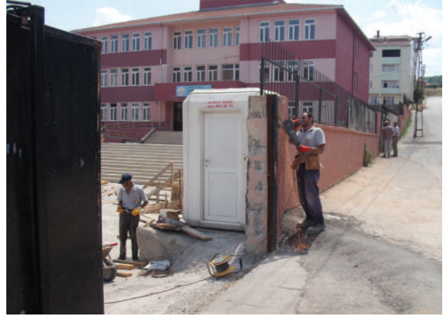
Okulların Giriş Kapılarındaki Tadilatlar Yapıldı.
