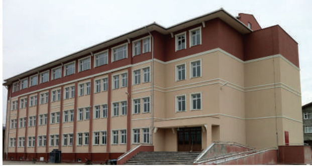
Yapımı Büyük Ölçüde Tamamlanan Mecidiye Mahallesi İlköğretim Okulu
